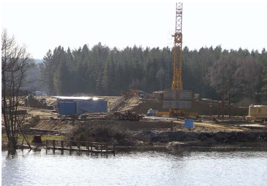
Der pilotes som bæreflade til den nye bro.
